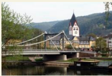
Die neue Lahnbrücke in Nassau
