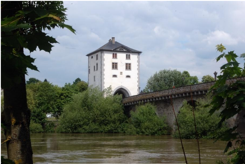
... und gelangen alsbald an die Alte Lahnbrücke
