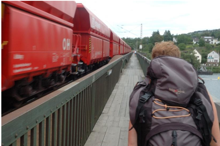
Über die Gülsener Eisenbahnbrücke gelangt man an das andere Moselufer
